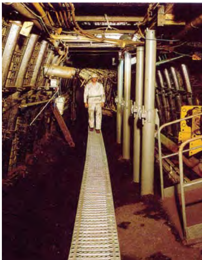
Pochůzná lávka v důlní chodbě
