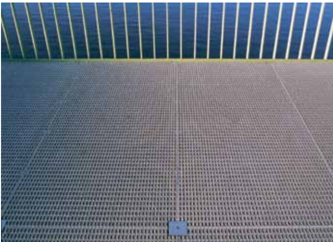
GFK-Gitterroste als Fußgängerbrückenbelag
